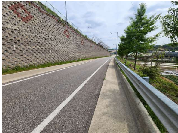
하부 포장부 전경
