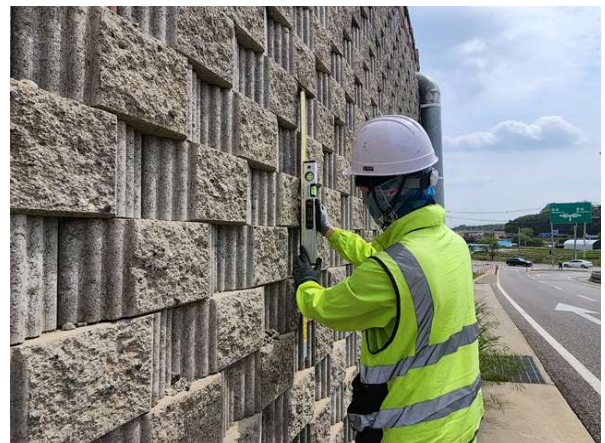
경사계를 이용한 경사도 측정
