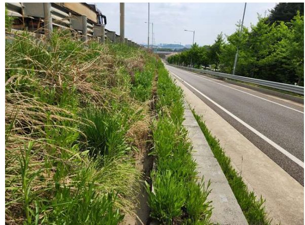
상부 배수로 전경
